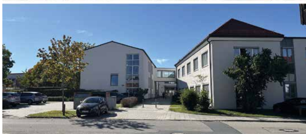
Erweiterungsanbau an der Grundschule
